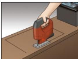
Öffnung entsprechend den inneren Abmessungen des "Mini" mit Stichsäge ausschneiden.
