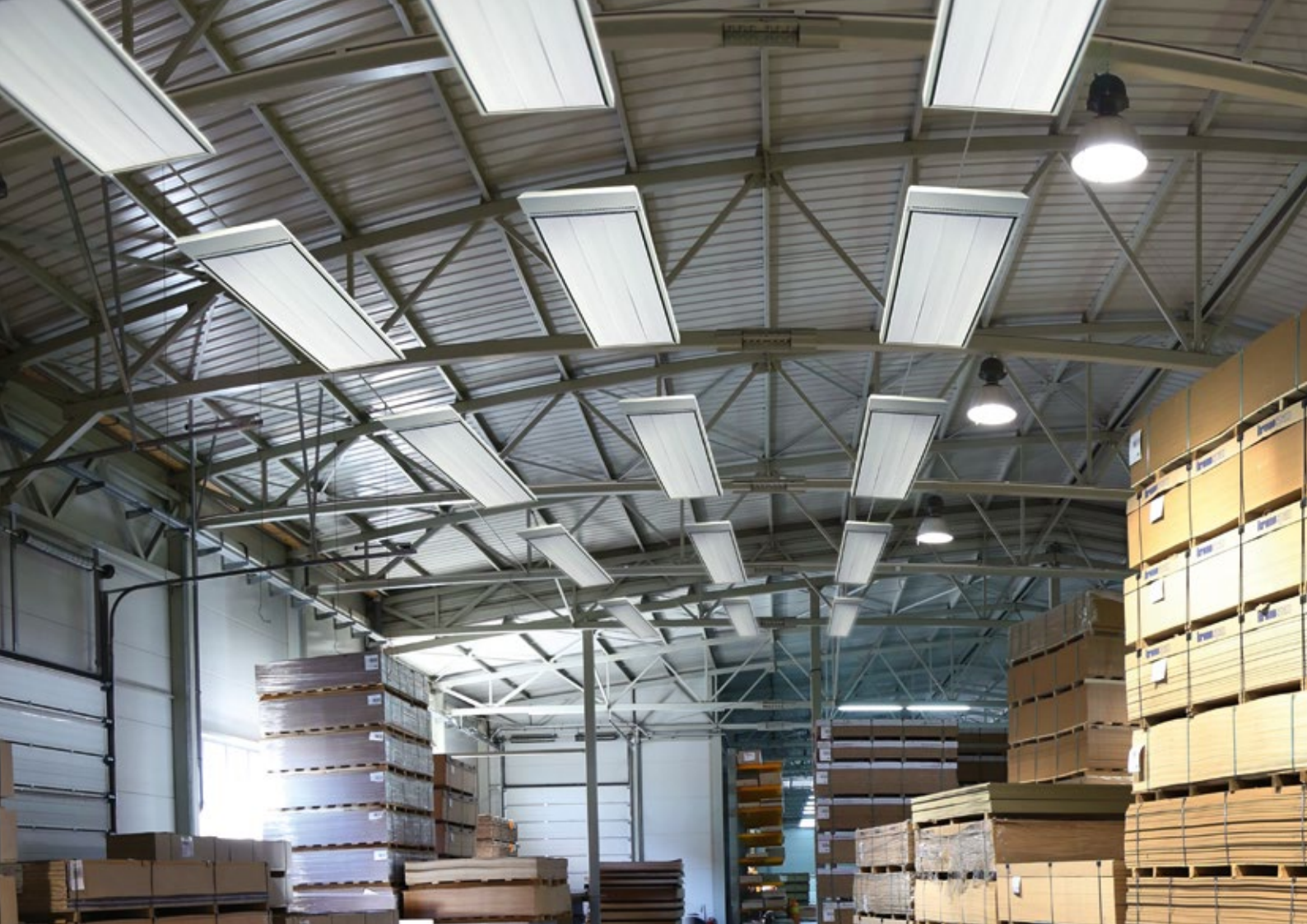
Infrarot-Hochtemperatur-Strahler - Deckenmontage in Lagerhalle
