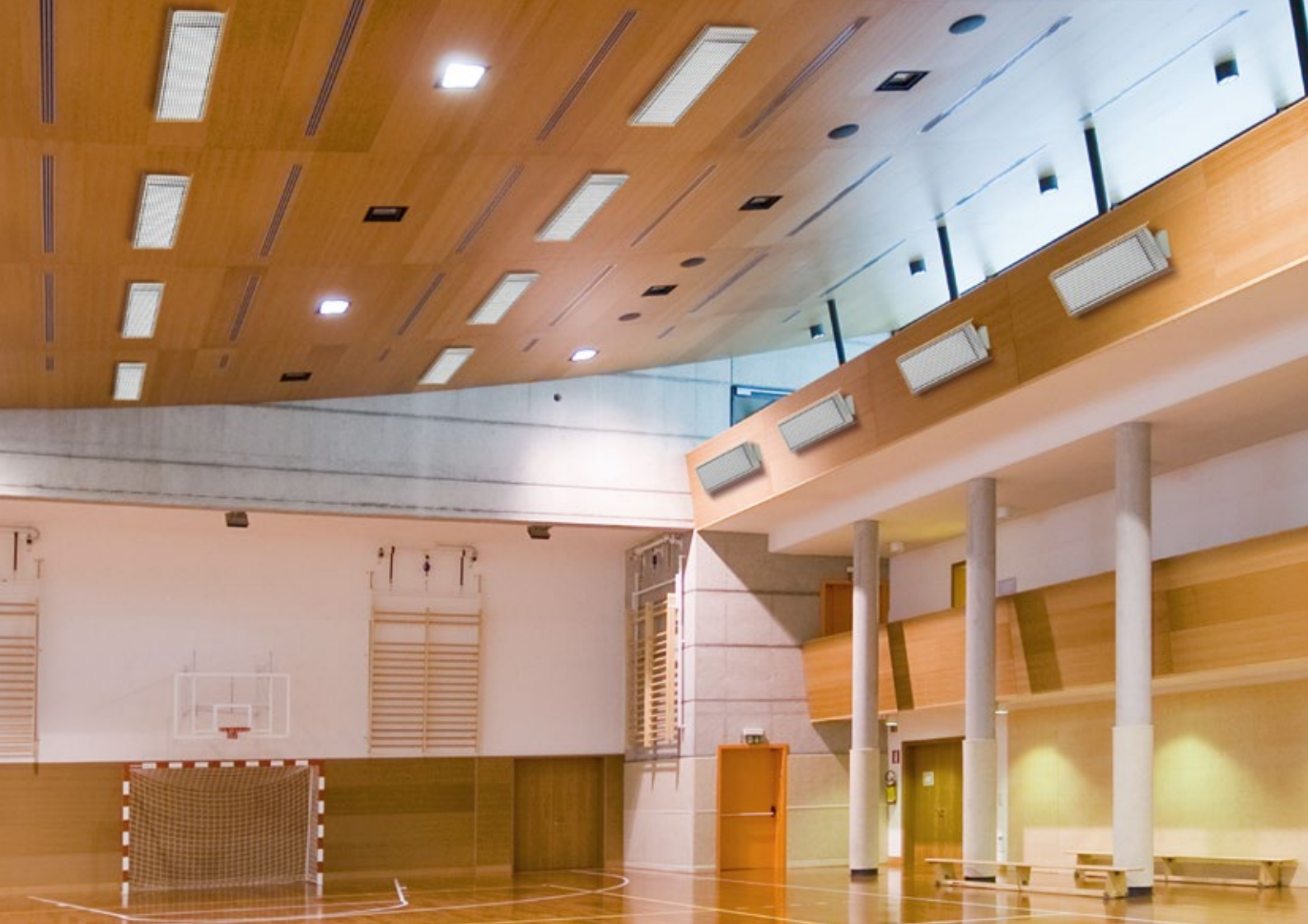
Infrarot-Hochtemperatur-Strahler mit Schutzgitter - Decken- und Wandmontage
