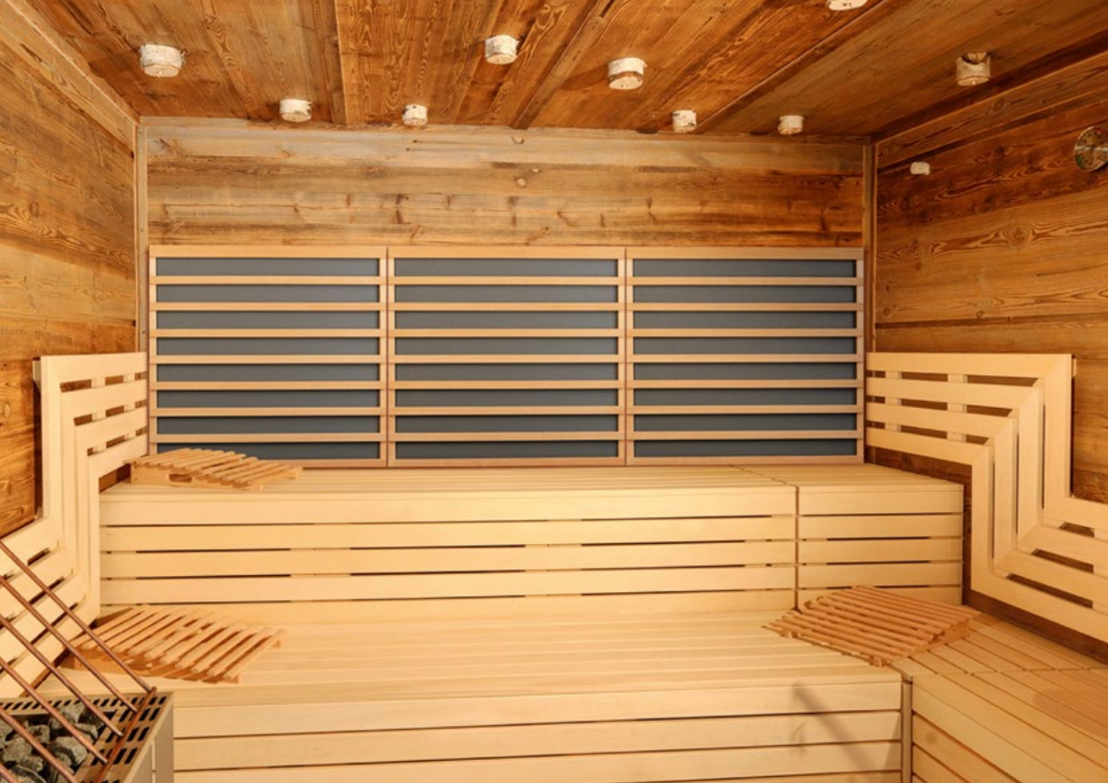
Wärmeplatten VARIO - 7001 Grau (Standard) in Sauna-Kabine nachträglich eingebaut
