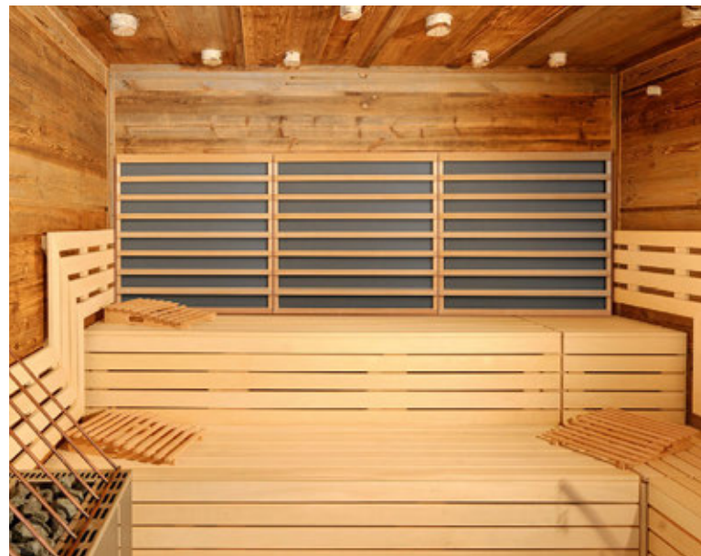
Wärmeplatten VARIO in Sauna-Kabine nachträglich eingebaut
