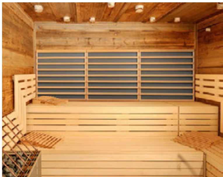
Wärmeplatten VARIO in Sauna-Kabine nachträglich eingebaut
