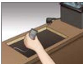
230 V Stromversorgung installieren und für ausreichend Zutluft im Bodenbereich sorgen.
